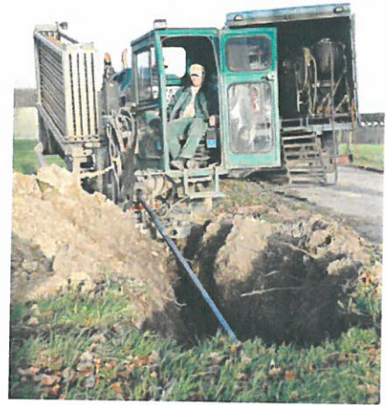
Horizontal-Bohranlage im Einsatz.
