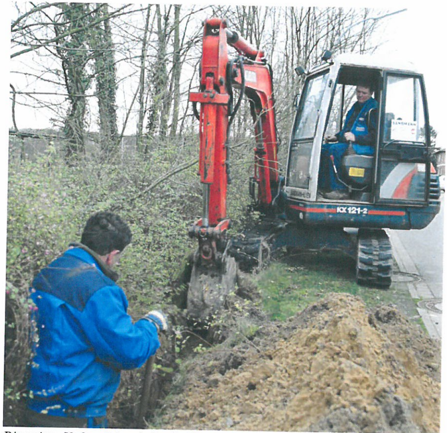
Die meisten Verlege-Jobs erledigt der Minibagger. Der Mann im Graben entfernt Steine.
