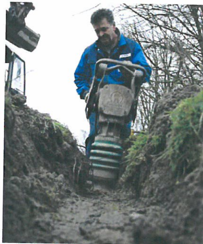
Mit dem Rüttelstampfer von den Grabenrändern zur Mitte hin arbeiten.
