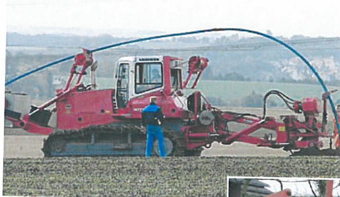
Links: Bei größeren Entfernungen und steinarmen Böden lassen sich Leitungen auch einpflügen. Unten: Kompakte Grabenfräse im Einsatz.
