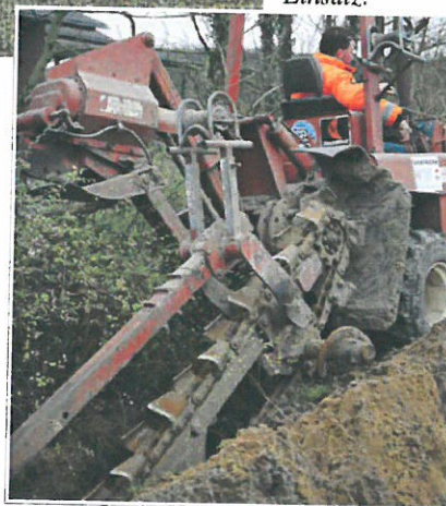
Links: Bei größeren Entfernungen und steinarmen Böden lassen sich Leitungen auch einpflügen. Unten: Kompakte Grabenfräse im Einsatz.
